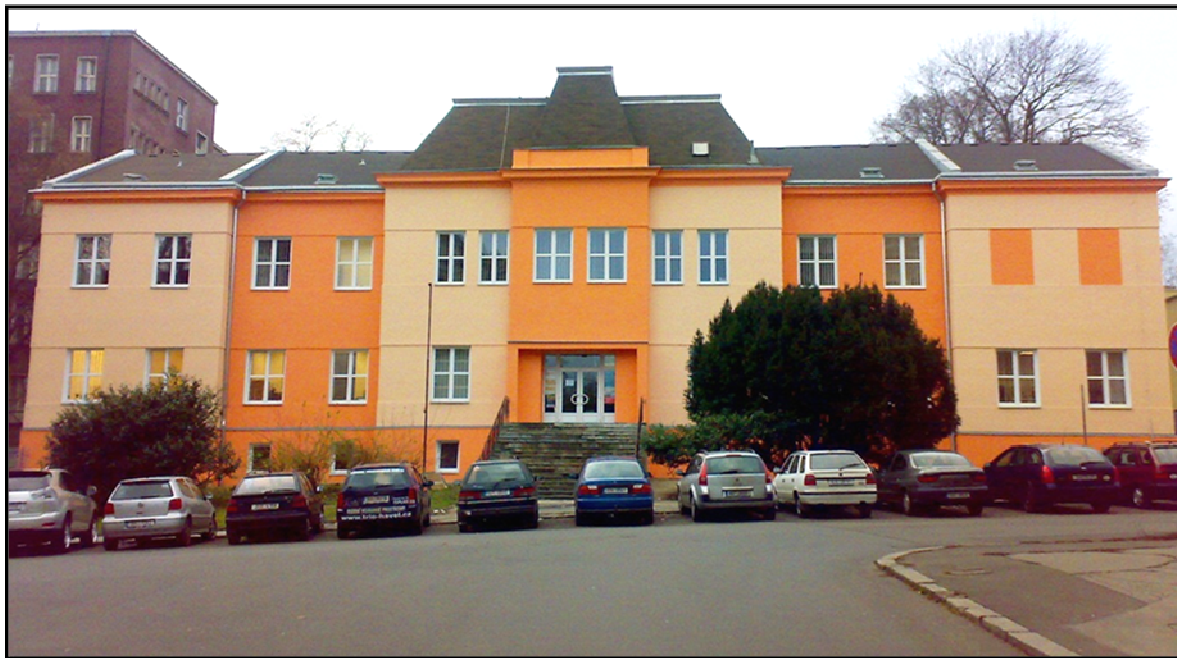
budova KTMI, přední pohled
